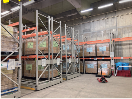
博多区月隈にある福岡市の防災備蓄倉庫
