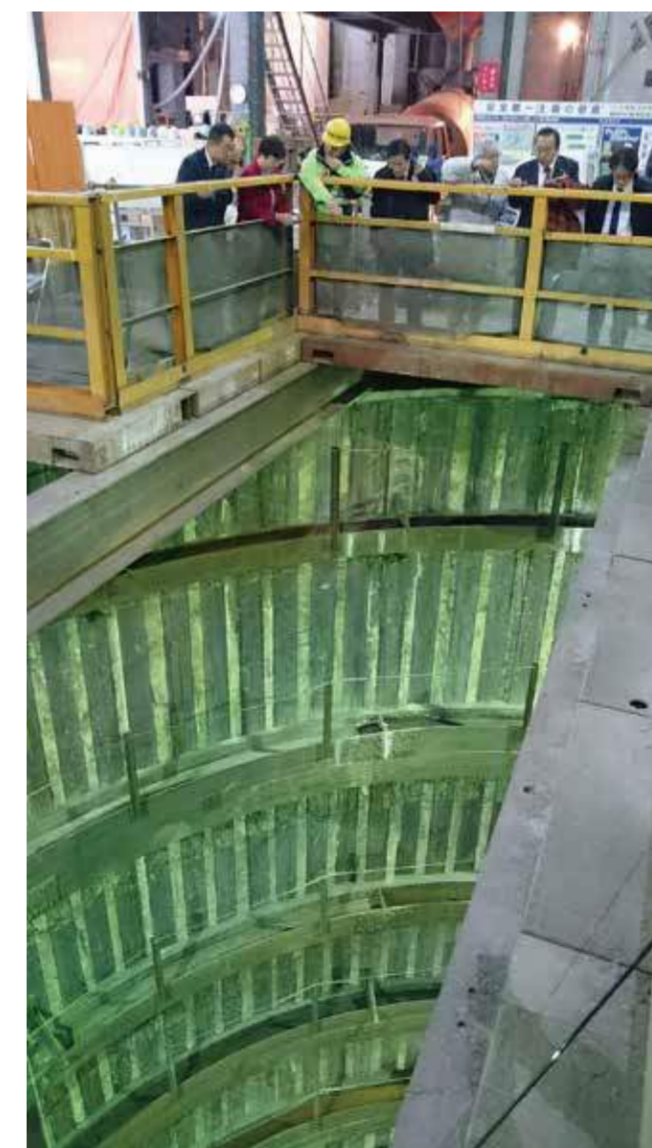
地下鉄工事の坑道の入り口を調査する共産党市議団 (昨年12月)
