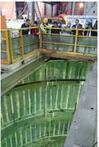
工事現場へ進入する立坑を調査する共産党市議団(11月26日)
