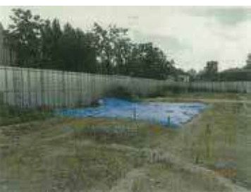
土壌汚染の「飛散防止」としてブルーシートをかぶせただけの「対策」。「粘土質の土をかぶせるか、コンクリートで対策を」と専門家は語ります。（市の提供写真より）
