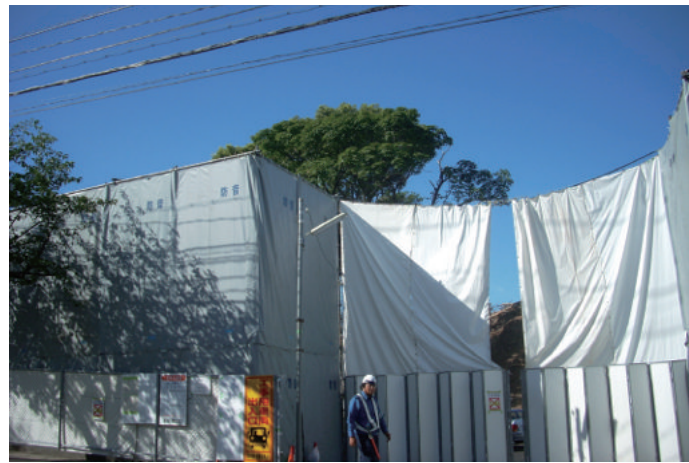
工事が進められる現地
